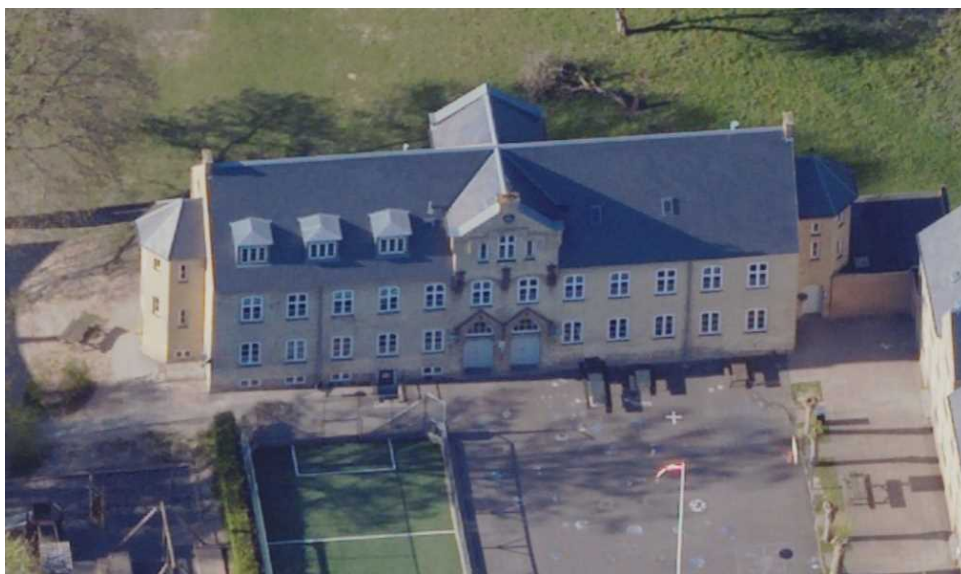
Den side af bygningen, hvor der ønskes etableret nye kviste:
